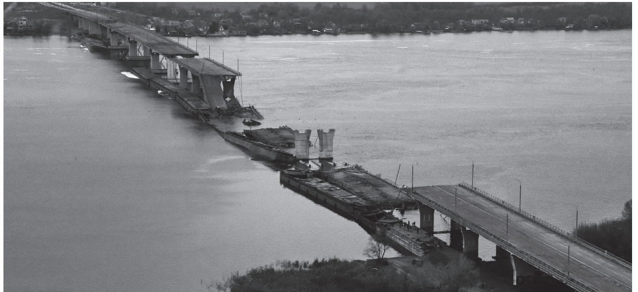
Las tropas blancas rusas destruyen el puente sobre el río Dniéper en su retirada de Jersón
